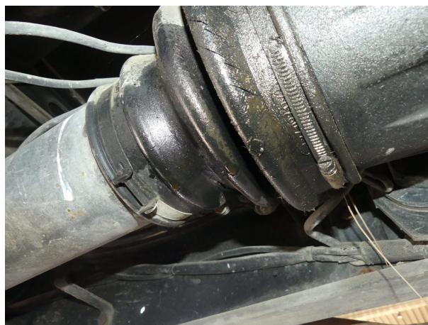
Beschädigung 11: Getriebe: Getriebe - undicht - befunden ggf. instandsetzen
