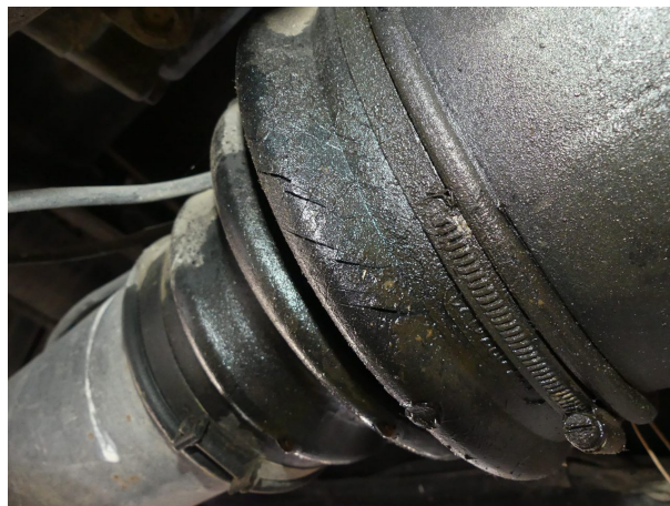
Beschädigung 11: Getriebe: Getriebe - undicht - befunden ggf. instandsetzen
