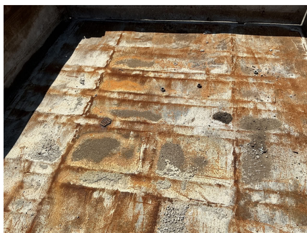
Beschädigung 7: Dreiseitenkipper: Kipperboden - verschlissen - instandsetzen
