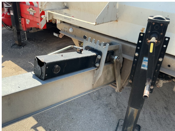
Beschädigung 6: Rahmen: Rahmen (Deichsel) - Spiel - instandsetzen
