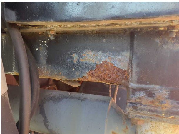
Beschädigung 2: Rahmen: Rahmen - Korrosion - instandsetzen
