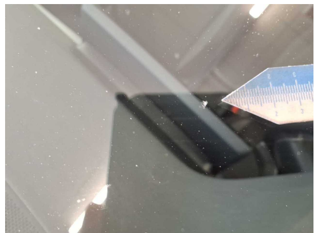
Beschädigung 3: Verglasung: Frontscheibe - gebrochen / gerissen - erneuern
