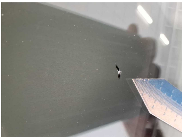
Beschädigung 4: Verglasung: Frontscheibe - gebrochen / gerissen - erneuern
