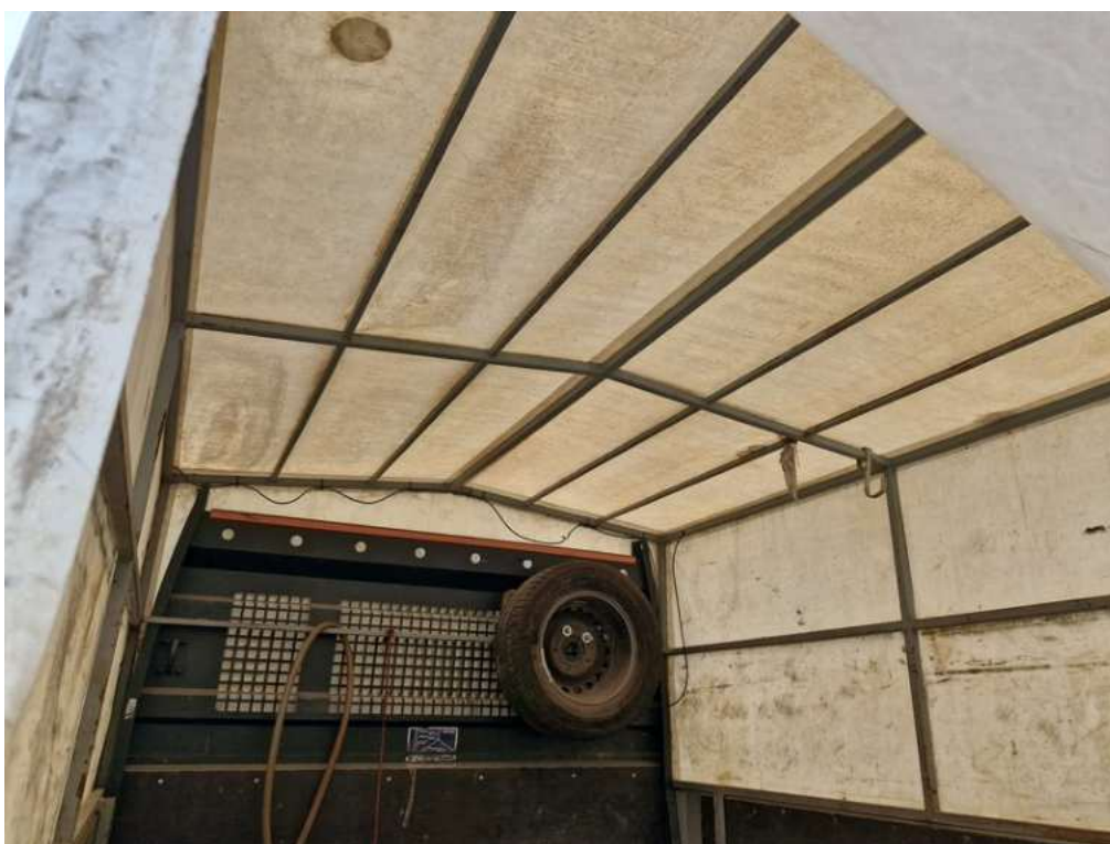
Viz popis k poškození č. 18
