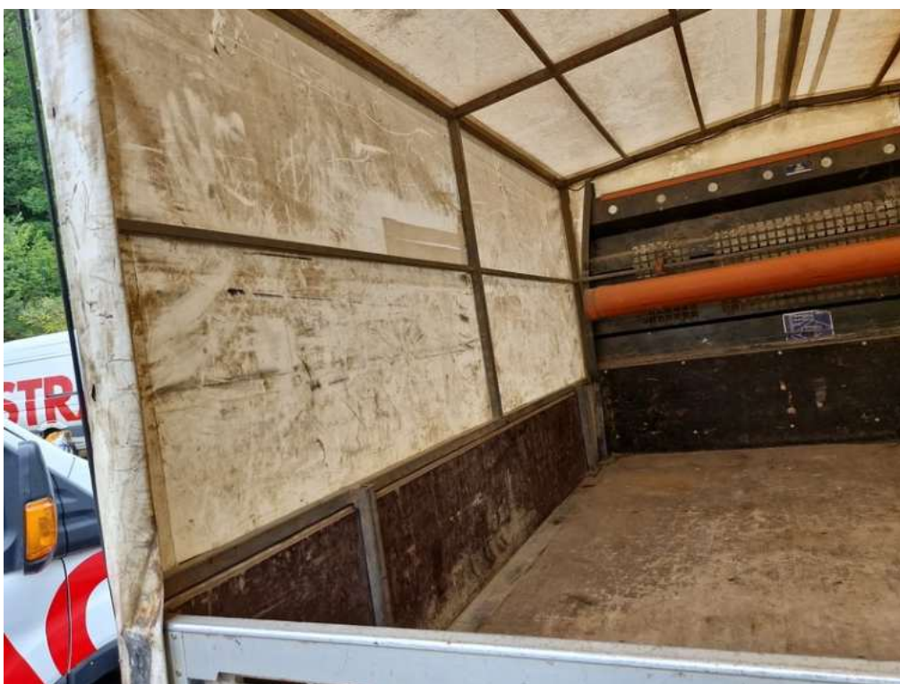
Viz popis k poškození č. 19
