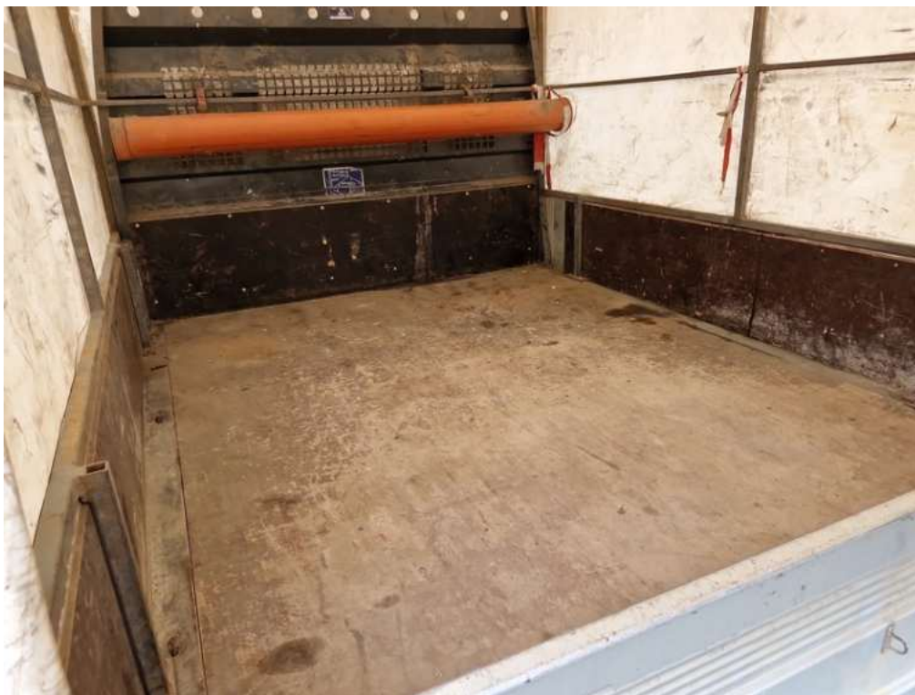
Viz popis k poškození č. 19
