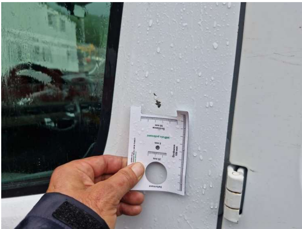
Viz popis k poškození č. 6
