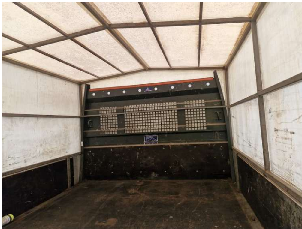
Viz popis k poškození č. 10
