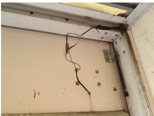
Beschädigung 5: Zusatzleuchte: Arbeitsscheinwerfer - ohne Funktion - erneuern
