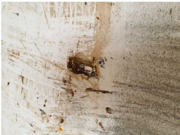
Beschädigung 4: Koffer: Seitenwand rechts - Löcher - instandsetzen
