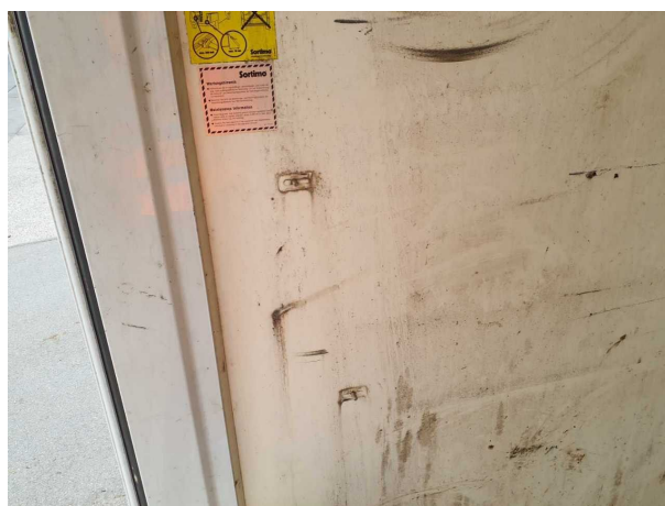
Beschädigung 3: Koffer: Seitenwand links - Löcher - instandsetzen
