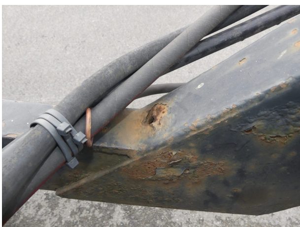
Beschädigung 1: Rahmen: Rahmen - Korrosion - instandsetzen und lackieren
