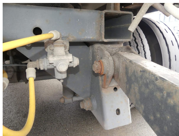
Beschädigung 3: Rahmen: Rahmen (Scherenbolzen) - lose - instandsetzen
