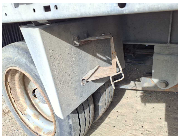
Fehlteil 1: Ausrüstung: Unterlegkeil - fehlt - erneuern
