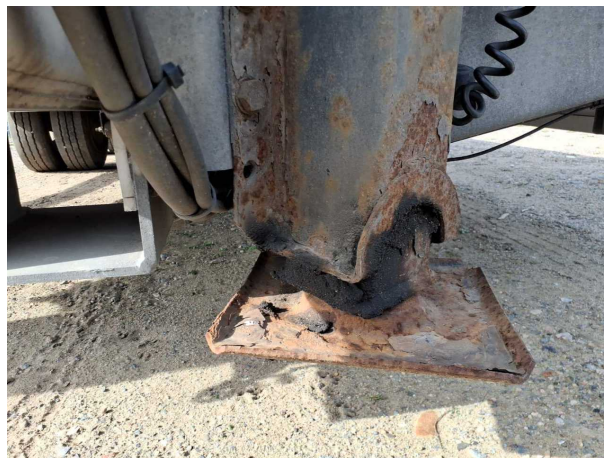
Beschädigung 5: Sonstiges: Fahrzeug (Stützbein , und Korrosion) - verformt - erneuern
