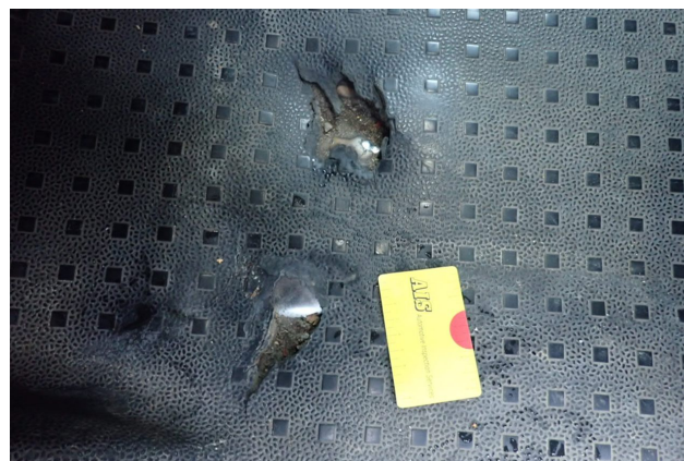
Beschädigung 9: Verkleidungen/Abdeckungen: Bodenbelag vorn Mitte - gebrochen / gerissen - erneuern
