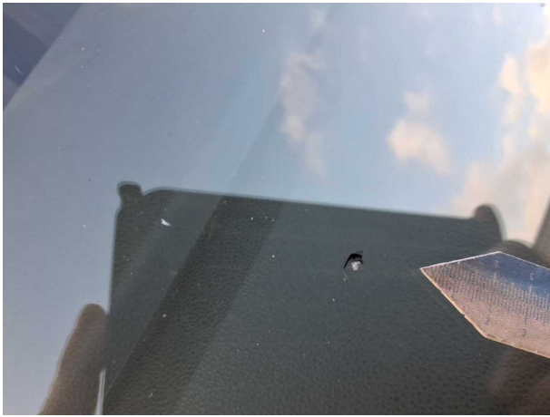
Beschädigung 4: Verglasung: Frontscheibe - gebrochen / gerissen - erneuern
